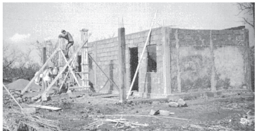
Benin: costruzione della maternità
